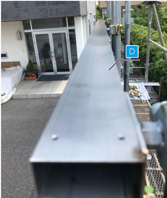
14. 金物 **D** を設置したパネル上部に固定します。
